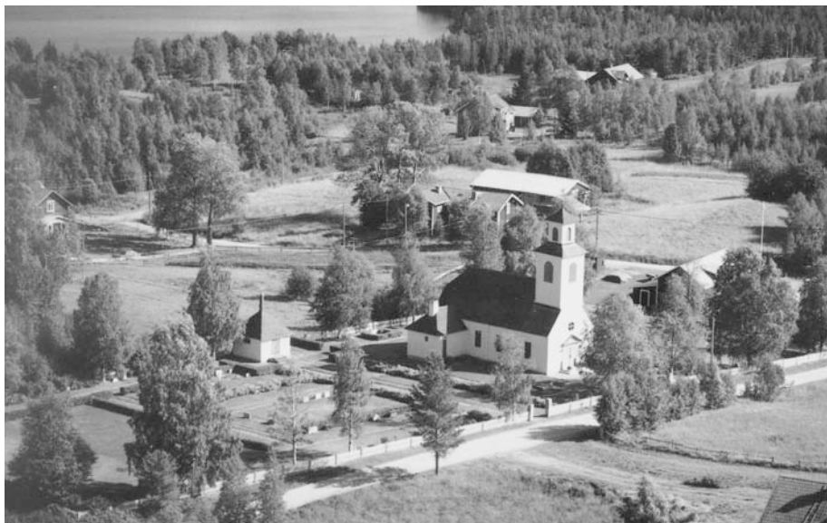
Bild 2.2: Ängersjö kyrka med omnejd. Kyrkan byggdes under åren 1737–47, byggdes om 1780, försågs med torn i väster 1847 samt restaurerades 1931 då exempelvis en ny sakristia uppfördes.
